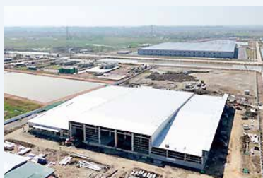
▲建設工事の様子 (10月)
